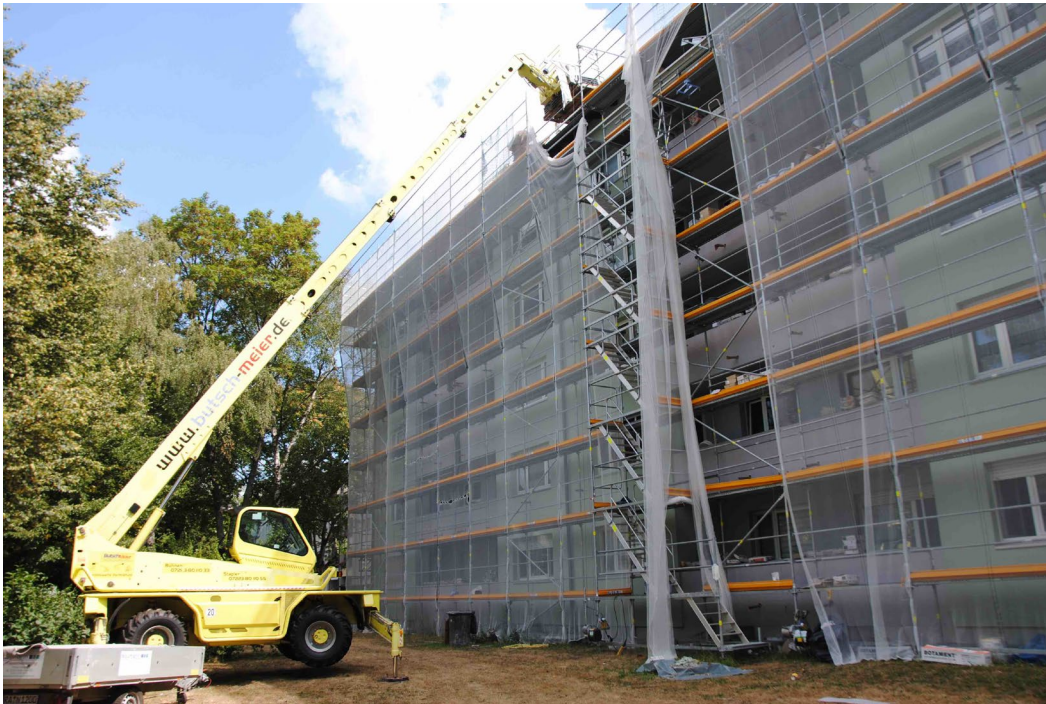
Abbildung 8: Transport der SOLINK-Kollektoren auf das Dach des Mehrfamilienhauses
