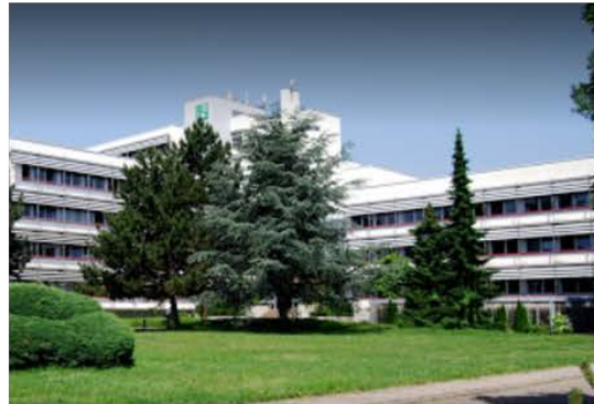
Fraunhofer IOSB, Karlsruhe
