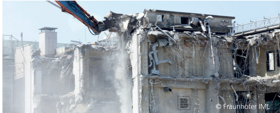
Anfallende Abbruchmaterialien beim Abriss eines Gebäudes.
