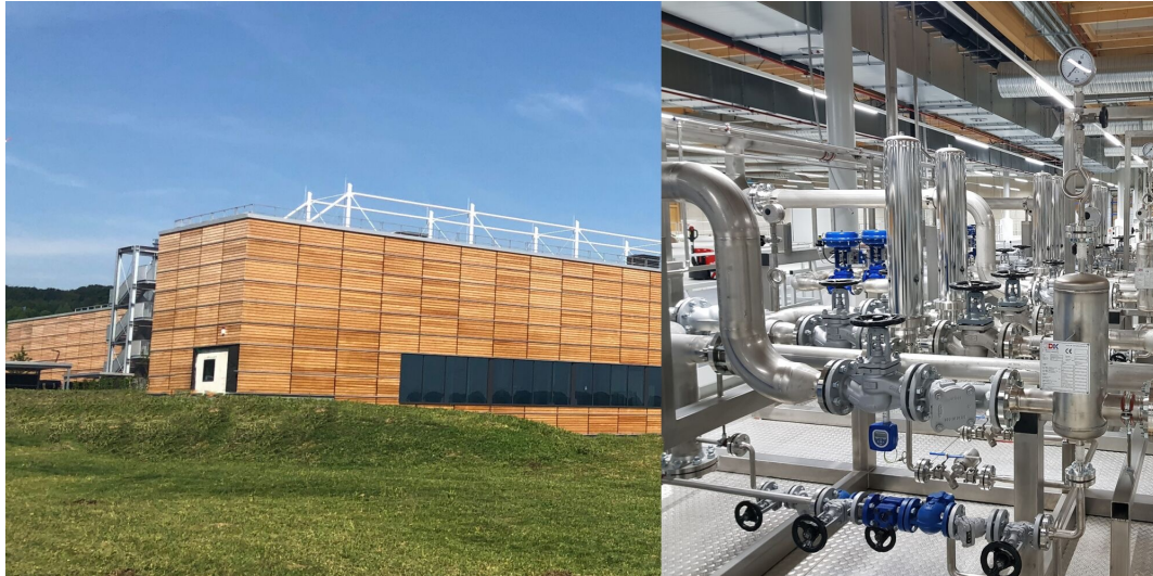
BRITA (Wasserfilter) Bad Camberg
