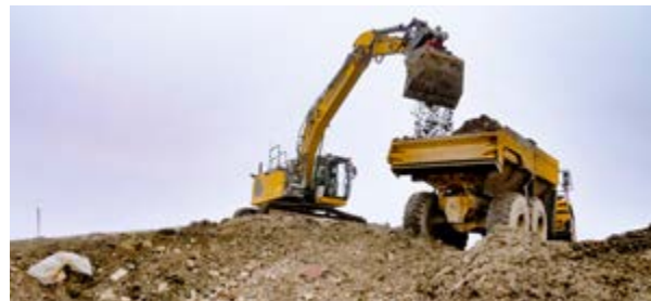
Autonome Beladung durch einen Bagger in einer Deponie. (Foto: Fraunhofer IOSB)
