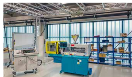
Demo-Aufbau in Karlsruhe: Schaltschrank, Spritzgussmaschine und Traversensystem mit RICE-Sensorik.
