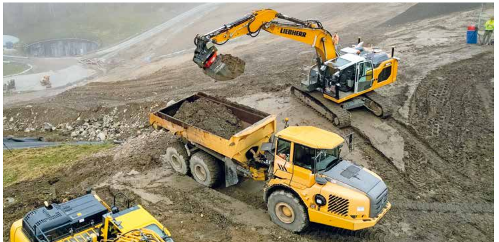
Der Bagger ALICE belädt autonom einen Muldenkipper bei der Sanierung einer Deponie.
